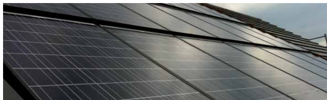
Sistemul InDax cu montaj încastrat în învelitoare
